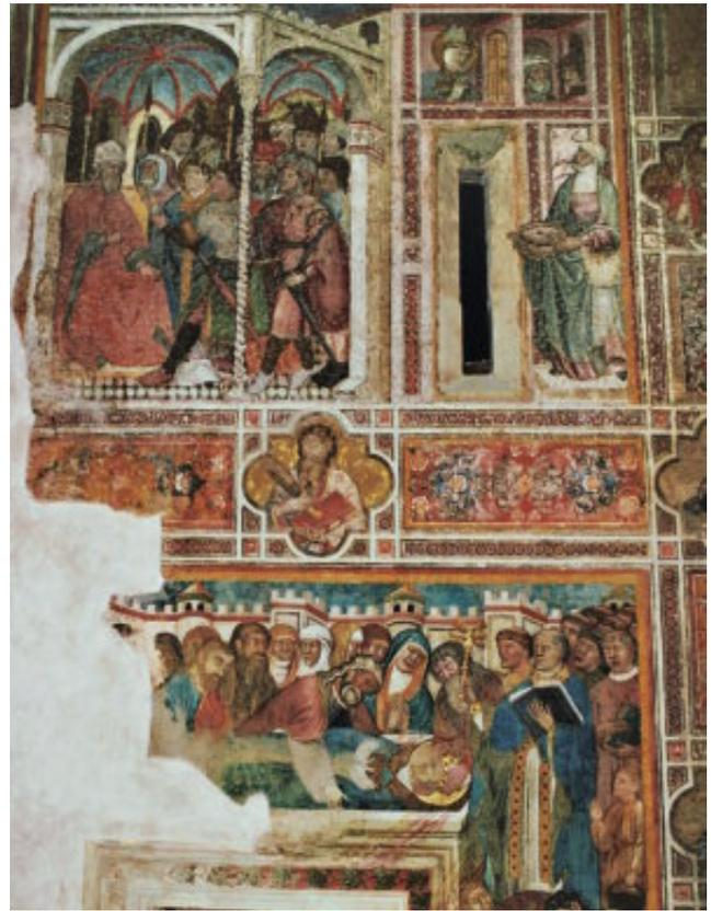
Figs. 39 y 40 Muro inferior oriental antes y después de la restauración, donde se puede apreciar la pérdida del mortero por las filtraciones de agua
